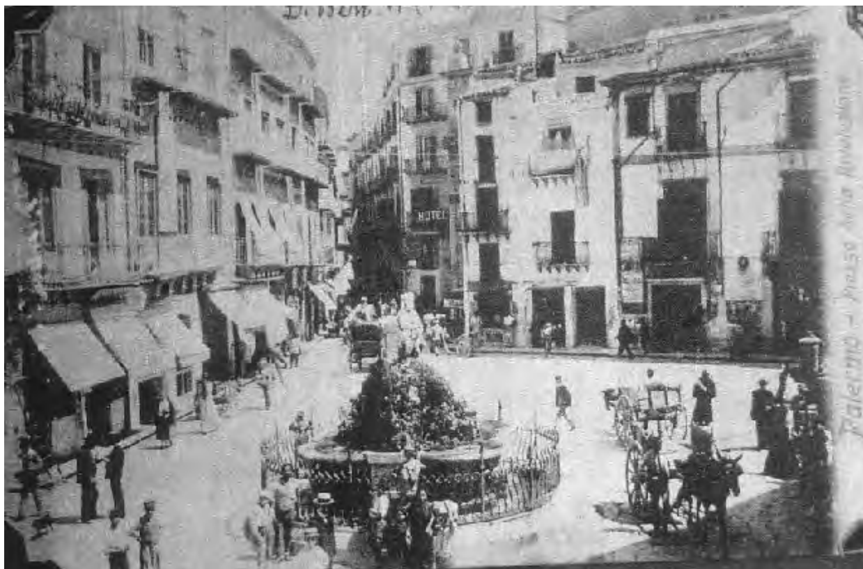
Fig. 85. La Piazza della Fieravecchia alla fine dell'Ottocento; a destra si vedono le palazzine esistenti prima dell'attuale Albergo Paradiso.
