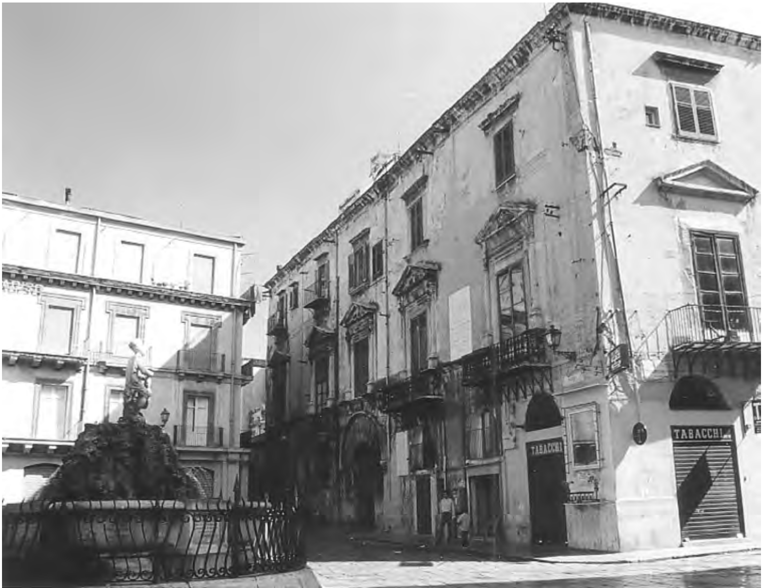
Fig. 41. Palazzo Scavuzzo a piazza Fieravecchia
